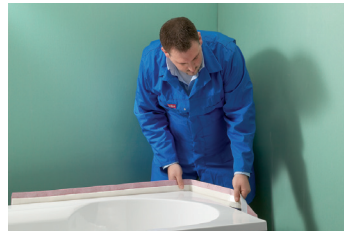
Band mit der Schallschutzseite an der Wanne anbringen.
