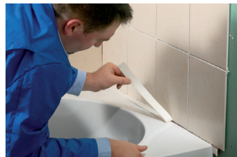
Zellstoffband entfernen.
