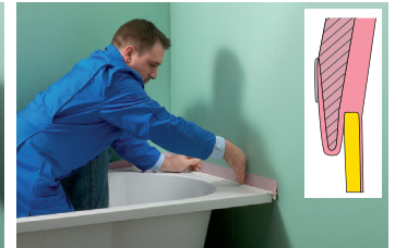
Wanne positionieren, Band schlaufenartig zusammenlegen und Fließ an die Wand anbringen.
