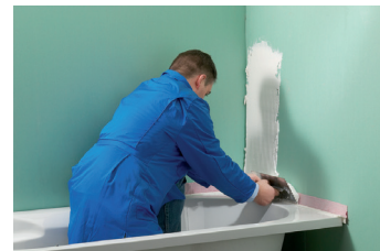
Fliesenkleber auf die Wand auftragen.
