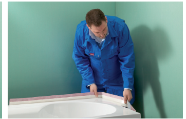
Band mit der Schallschutzseite an der Wanne anbringen.
