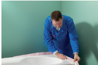
Zellstoffband zum Schutz vor Verschmutzung auf die Oberseite der Wanne umschlagen.
