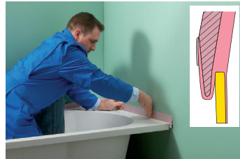
Wanne positionieren, Band schlaufenartig zusammenlegen und Fließ an die Wand anbringen.
