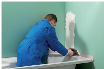
Fliesenkleber auf die Wand auftragen.
