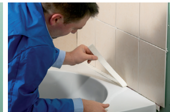
Zellstoffband entfernen.
