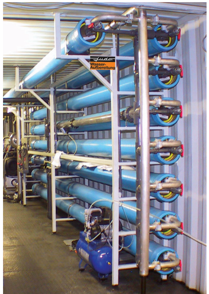
Membranrack Meerwasserentsalzungsanlage
