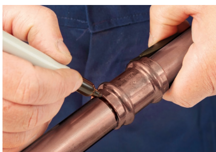
4. Zusammenbauen und die Einstecktiefe markieren
