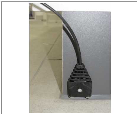
Abb. 10: Korrekte Befestigung Leckagesensor
